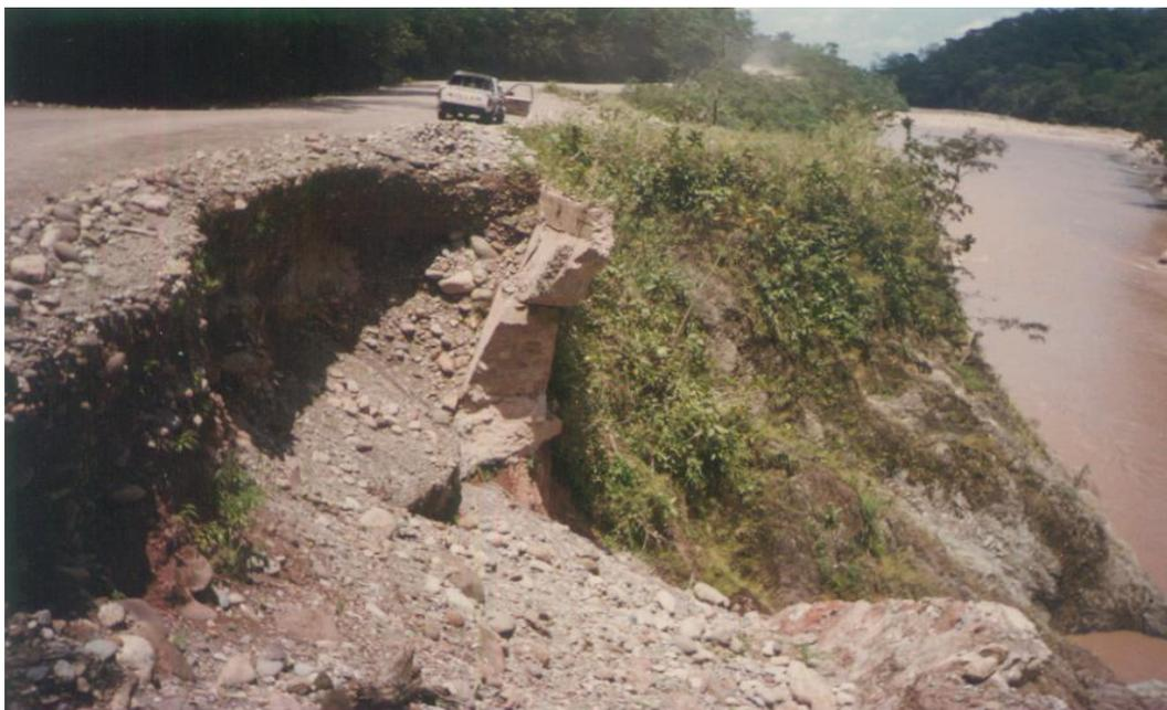
Foto XX Erosión lateral del río Yuracyacu cerca del Boquerón del Padre Abad que afecta la carretera Tingo María–Pucallpa y que ha destruido incluso el muro de protección
