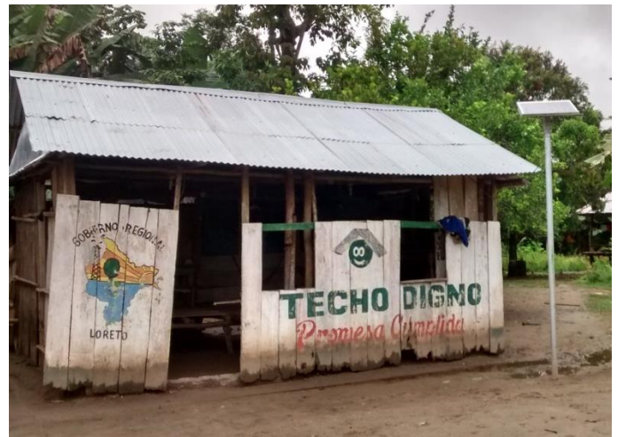
Casas con techo de calamina
