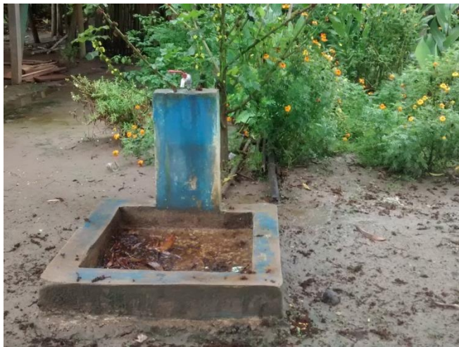
Pileta para distribuir agua a la comunidad
