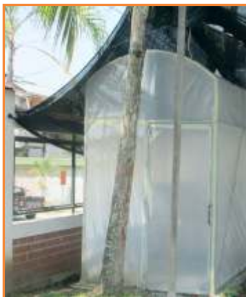
Ambiente de micro-túnel
