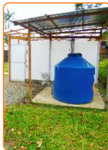
Tanque de agua
