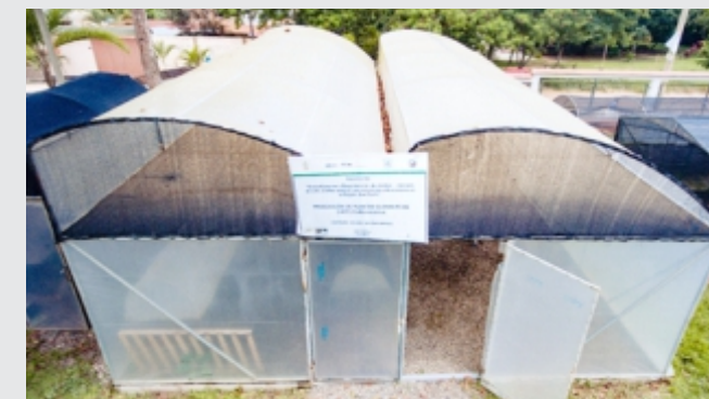
Figura 20. Vista externa del invernadero de producción clonal
